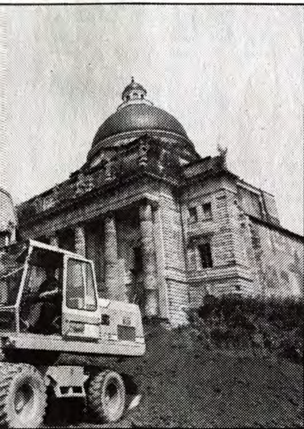
nämlich in den Neubau integriert werden (Foto mstritten. Fotos: Schnetzer/Strub
